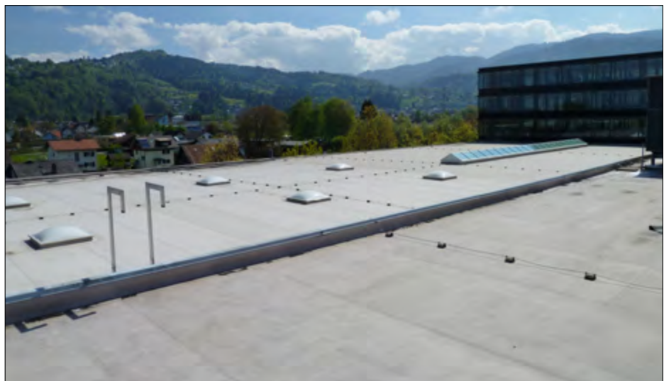
Bild 3: Übersichtsaufnahme Dachfläche des Objektes Meusburger in Wolfurt (Österreich)
