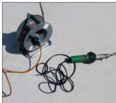
Bild 6: Problemlose Verschweissung von neuer auf alter Dachabdichtung ( Sarnafil® TS 77-18 ) Meusburger in Wolfurt (Österreich)
