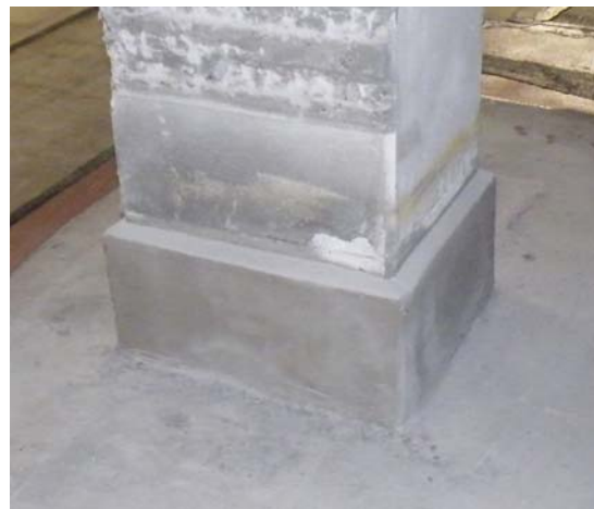
Abb.8: Aufbringen eines "Chloridreservoirs" am Stützenfuß durch eine zusätzliche Betonschicht.
