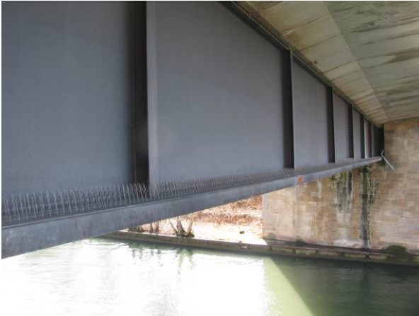
Bild 2: Guter Zustand der Korrosionsschutzbeschichtung einer Stahl-Betonverbundbrücke nach 48 Jahren.
