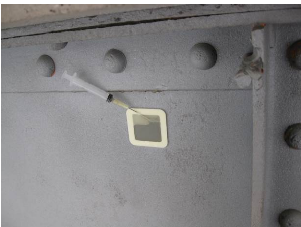
Bild 3: Prüfung eines frisch gestrahlten Stahlbauteils auf nicht sichtbare Verunreinigungen mit dem Bresle-Verfahren [11].
